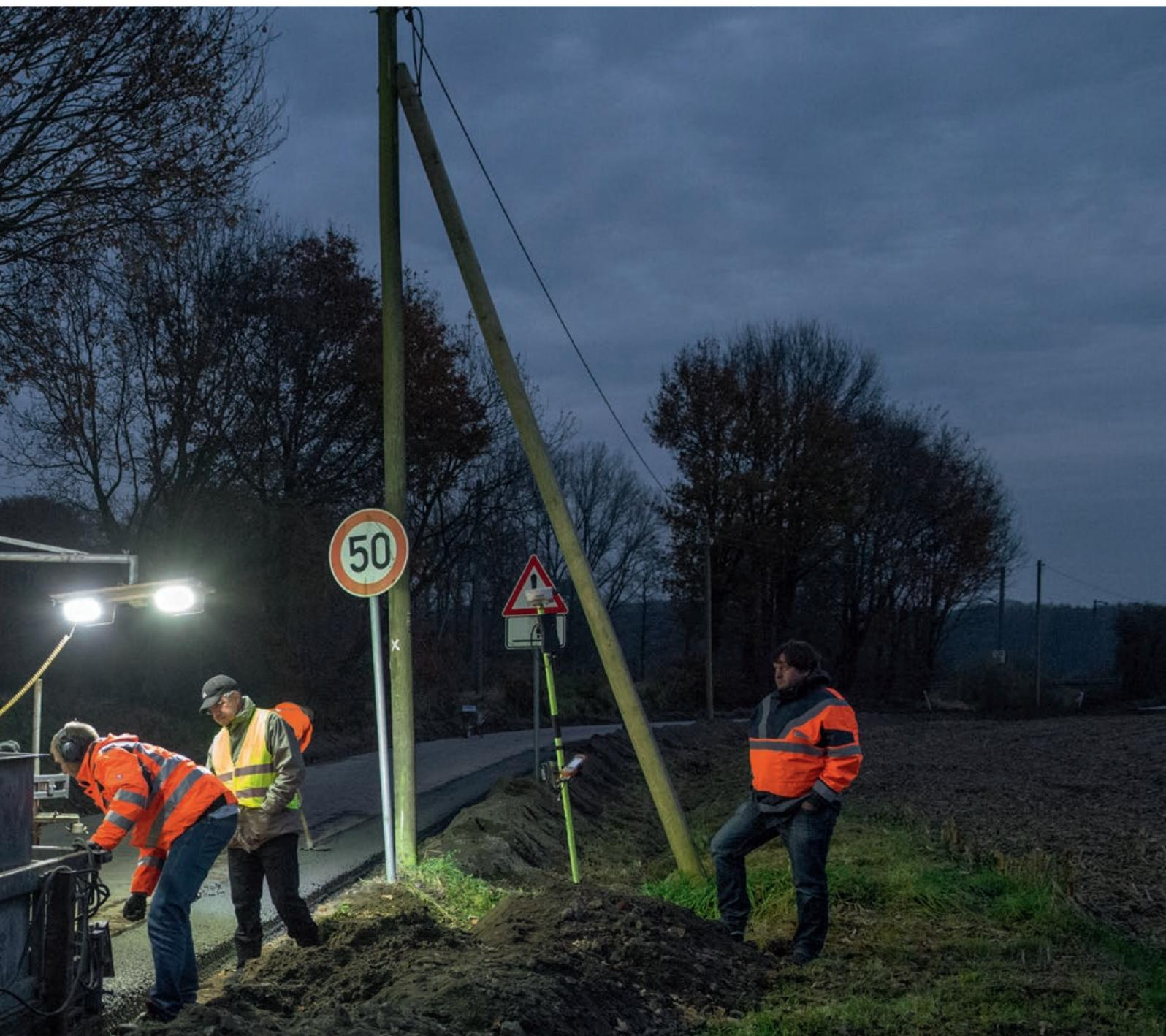
Bankette bilden bei den meisten außerörtlichen Straßen den seitlichen Abschluss der Fahrbahn und schließen somit direkt an den Rand- bzw. Seitenstreifen an. Bei schmalen Straßen ist oft ein Begegnungsverkehr ohne Befahrung der Bankette nicht möglich. Ebenso werden bei engen Autobahnbaustellen mit schmalen Fahrspuren häufig die Bankette von Lkw's befahren.
