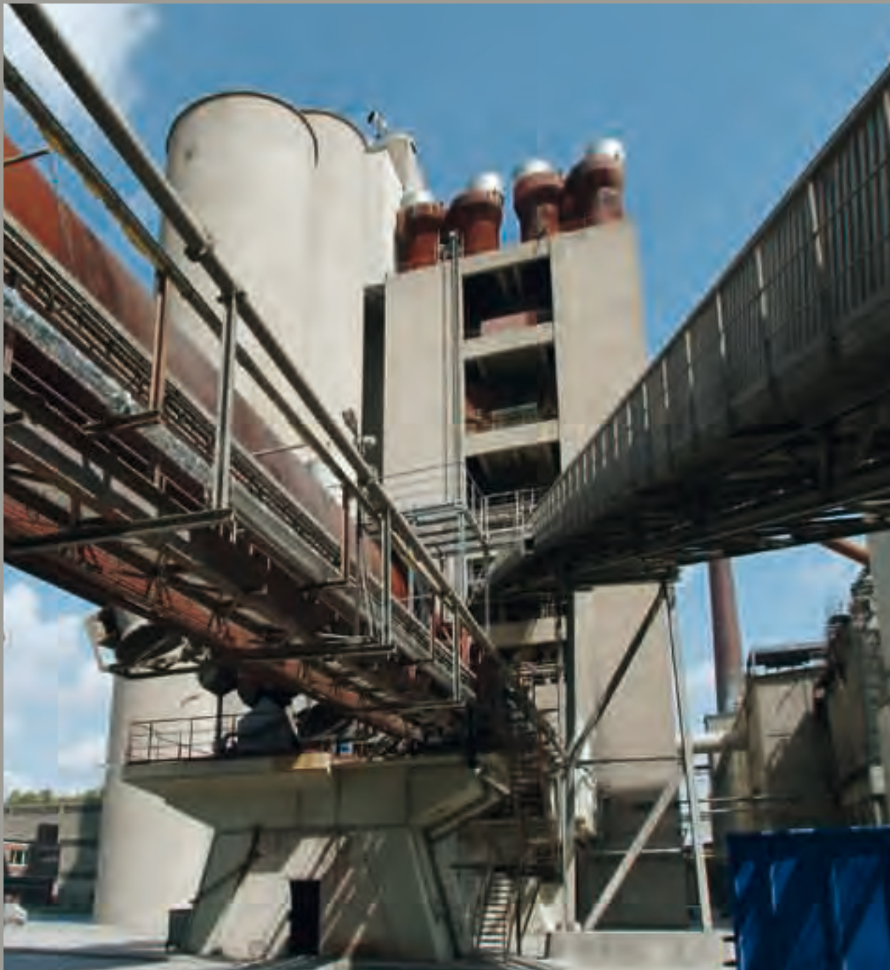
WÄRMETAUSCHEROFEN mit Wärmetauscharturm, 2000
