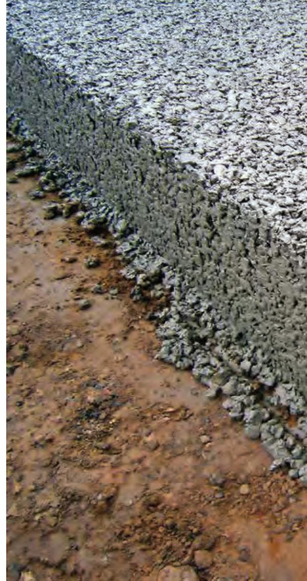
tenstreifen für den Schwerlastverkehr mit einem befestigten Bankett zu sichern, da aufgrund der schmalen Fahrspuren die Bankette häufig von Lkw befahren werden.
