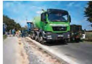
K 9, Meerbusch: Vorbereitete Unterlage für Bankettbeton mit Einbau-Equipment.
