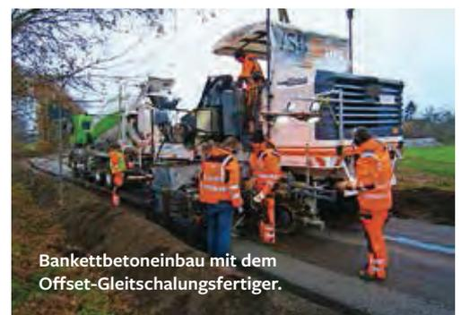
Bankettbetoneinbau mit dem Offset-Gleitschalungsfertiger.
