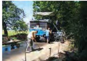
K 1054, Hasenhof: Bankettbetonstreifen hinter der Fertiger-Einbaumulde.
