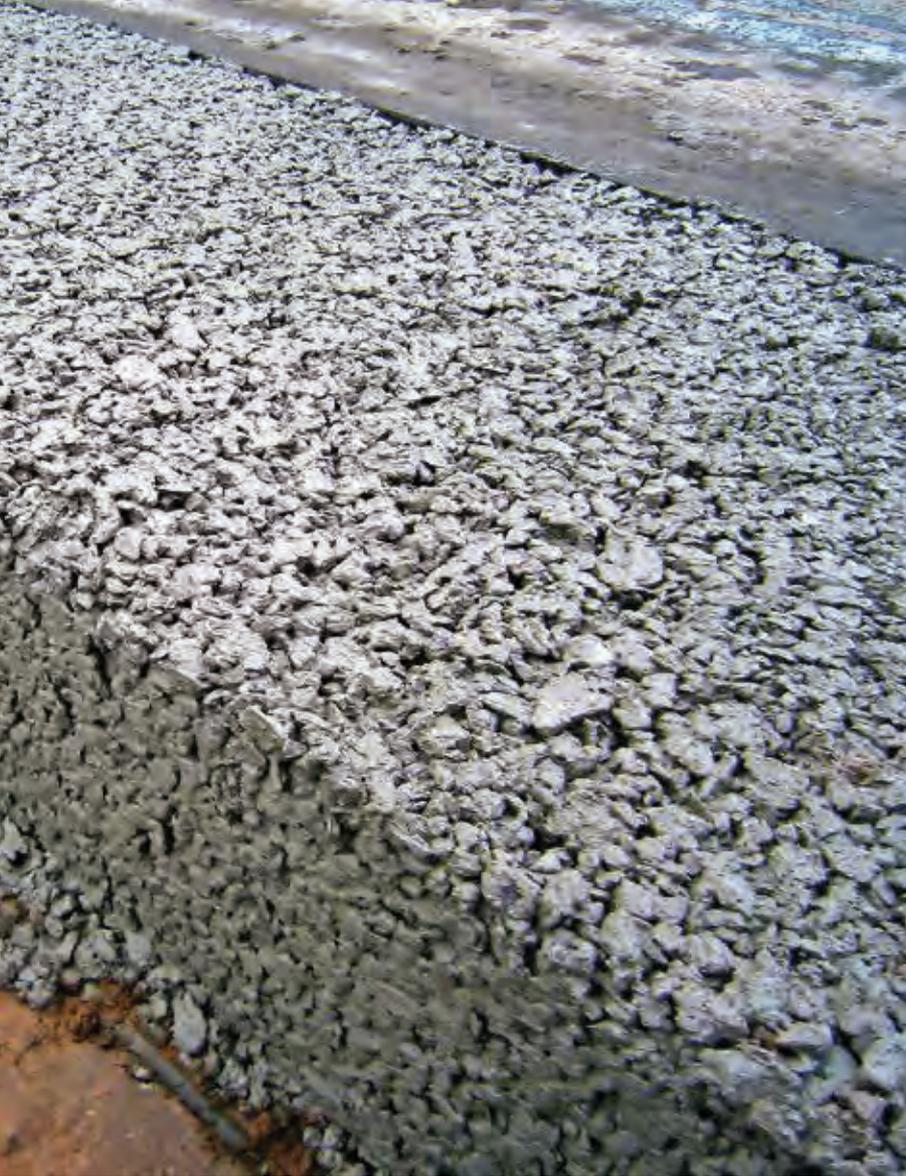
Detail: Querschnitt Bankettbetonstreifen.
