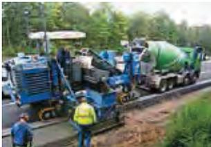
A 61, Gundersheim: Bankettbeton-Einbau mit dem Offset-Gleitschalungsfertiger.
