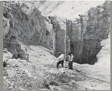
Zwei Arbeiter beim Bohren von Sprenglöchern mit PRESSLUFTHANDBOHRMASCHINEN im Rollloch-Abbau, Rationalisierter Abbau unter Vermeidung von Handverladung, 1935
