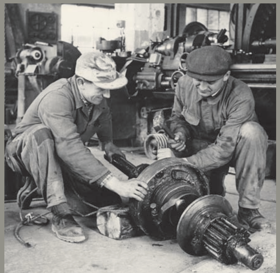
▼ GETRIEBEREPARATUR in der SCHLOSSEREI , 10.4.1956
