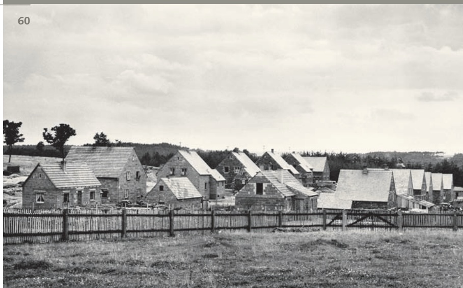
Unverputzte WERKSHÄUSER „Am Sand“, Oktober 1952
