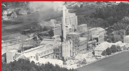
Luftbild von Nordwesten, LEPOLOFEN II IM BAU, 1958
