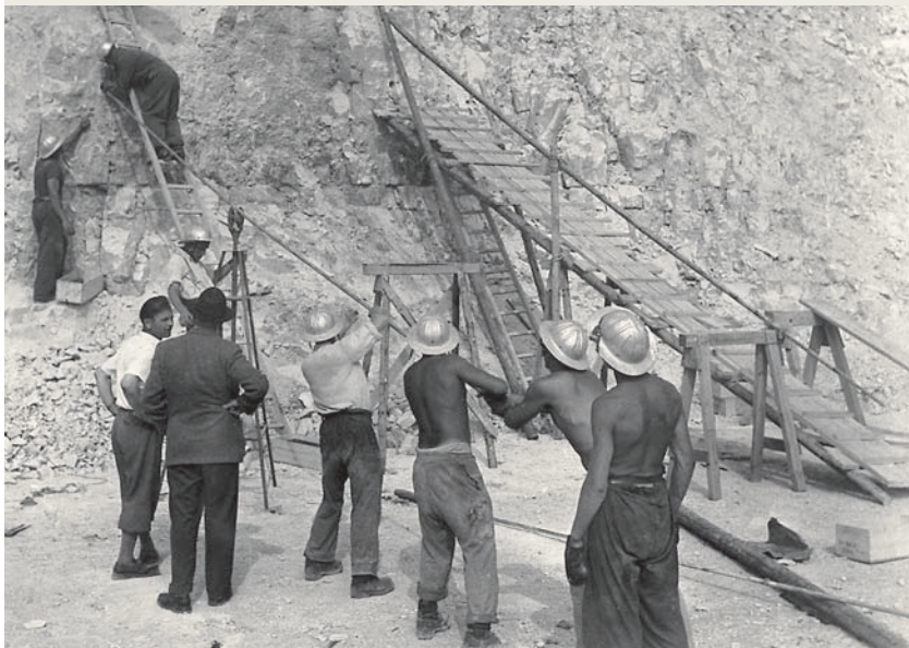
Vorbereitungen für die FUSSSPRENGUNGEN der zweiten Großbohrlochsprengung, 2.9.1955
