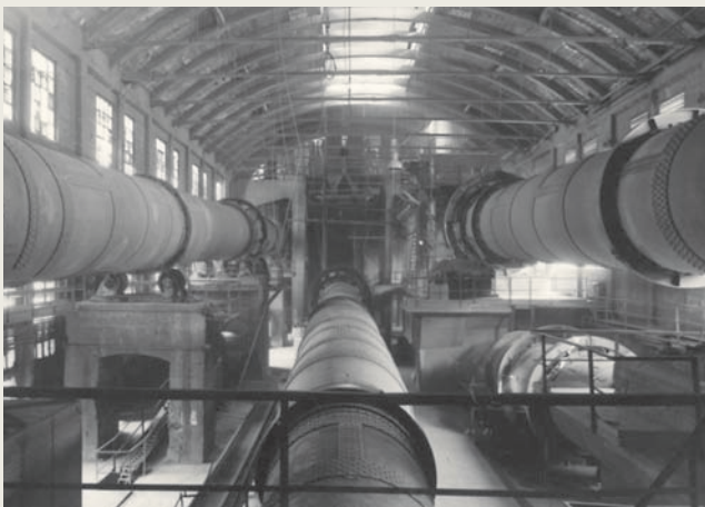
OFENHALLE , links Ofen I, mitte Ofen II, rechts Lepolofen, 13.5.1954
