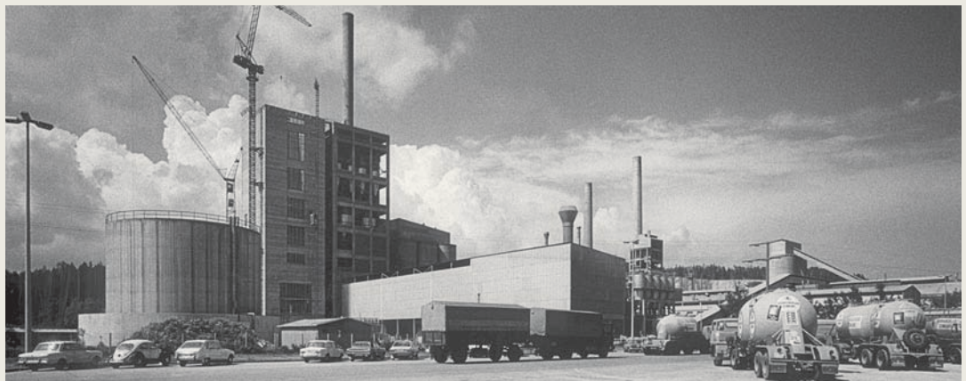
WÄRMETAUSCHERTÜRME, Turm III in Bau, 1974
