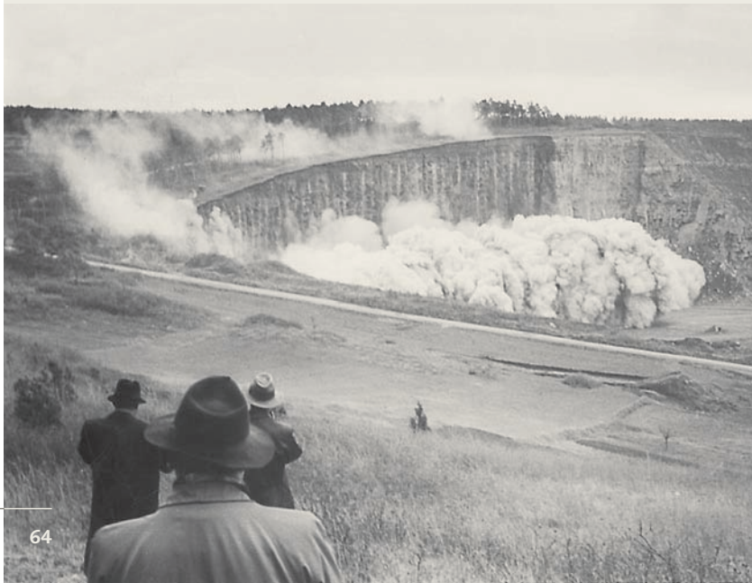
GROSSBOHRLOCHSPRENGUNG , 12.7.1957
