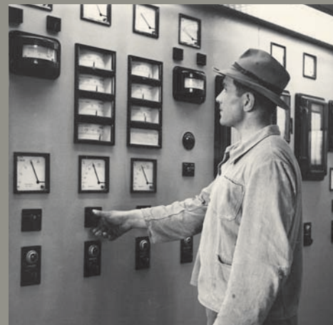
SCHALTSCHRANK am Lepolofen I, 10.04.1956
