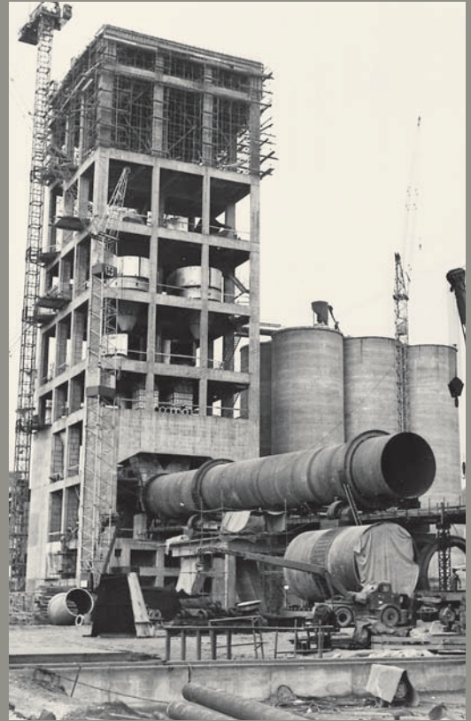
MONTAGE DREHOFEN V mit Wärmetauscherturm, Nov. 1967
