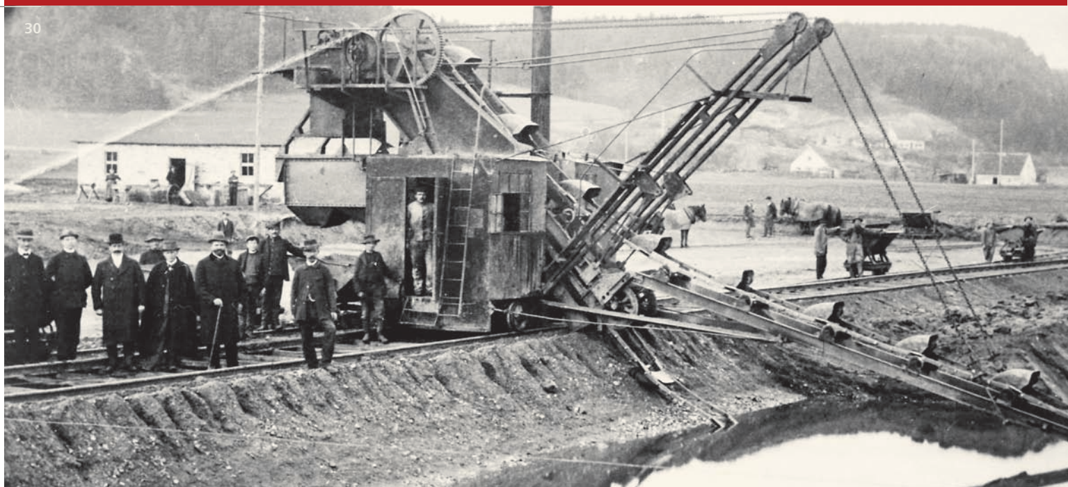
EIMERKETTENBAGGER DER FIRMA SEBASTIAN WEH, Tiefbaugesellschaft in Stuttgart. Kiesgewinnung für Errichtung des Bayerischen Portland-Cementwerks Burglengenfeld AG, Herbst 1912
