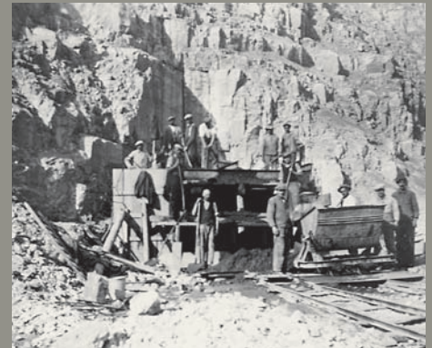
HANDVERLADUNG DER SOCKELZONE, die mit dem Rolllochverfahren nicht abgebaut werden konnte, ca. 1914
