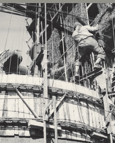
ARBEITSBÜHNE auf der Gleitschalung des Rohmehl-Rundsilos, 23.5.1959
