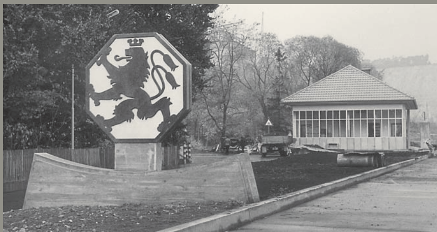
Alte Werkszufahrt mit neuer BETONSTRASSE , 1955
