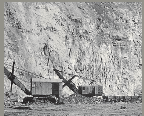
MENCK-LÖFFELBAGGER beim Beladen von Loren, 16.3.1953
