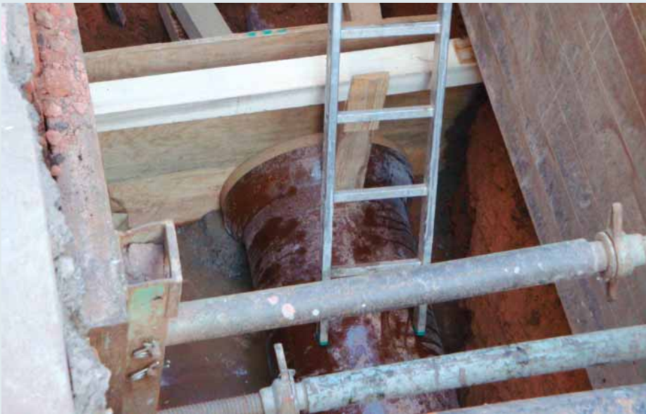
Abbildung 3: Beispiel einer Abschalung (Holztafel)
