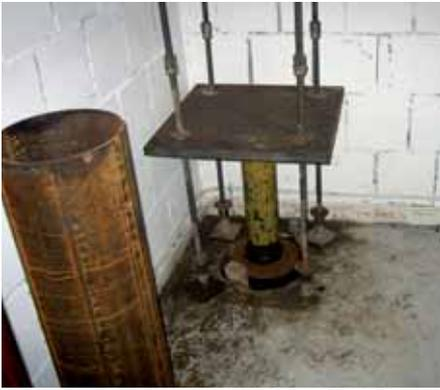
**Bild 7: Anheben der Bodenplatte mit einer hydraulischen Hubeinrichtung**
