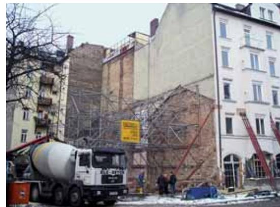
**Bild 5: Durch das Ausheben der Baugrube drohte das Nachbarhaus einzustürzen und musste daher mit einem Gerüst sowie zahlreichen Stützen gesichert werden.**
