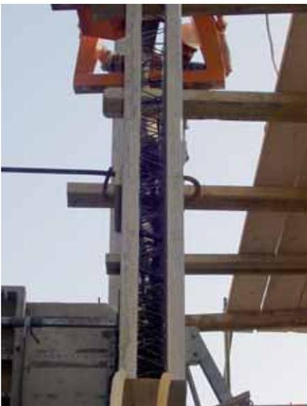
**Bild 10: Befüllen der Doppelwandelemente mit dem Krankübel**
