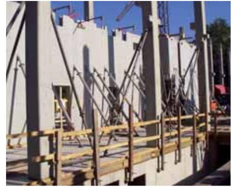
**Bild 9: Doppelwandelemente mit einer Höhe von 6 m für den Neubau der Feuerwache im Bereich der Messe Nürnberg**
