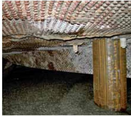
**Bild 8: Verfüllen des Zwischenraums zwischen Bodenplatte und Erdreich mit F6-Beton**
