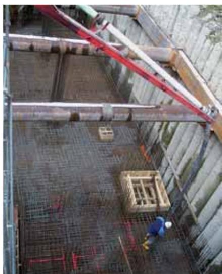
**Bild 6: Betonieren der Bodenplatte ohne Verwendung von Rüttlern** Foto: HeidelbergCement AG
