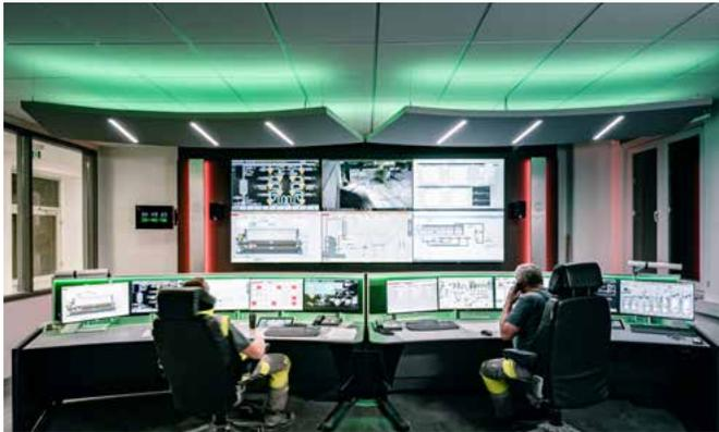
Qualität ist wichtig. Deshalb wird der gesamte Produktionsprozess vom zentralen Leitstand aus permanent überwacht und gesteuert. Alle Daten aus den Anlagen und dem Labor laufen hier zusammen. Hochqualifizierte Produktionssteuerer betreiben und sichern die Anlage mit Unterstützung modernster Mikroprozessortechnik.
