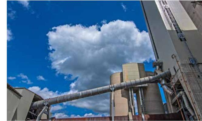
Das Brennen des Rohmehls erfolgt heute hauptsächlich in Drehrohrofen mit Zyklonvorwärmer. Nachdem im Zyklonvorwärmer und Calcinator das CO<sub>2</sub> zu großen Teilen aus dem Rohmehl ausgetrieben wurde, wird es im Drehofen bis auf ca. 1450°C erhitzt. Durch chemische Umwandlung, die so genannte Sinterung, entsteht ein neues Produkt: der Zementklinker.
