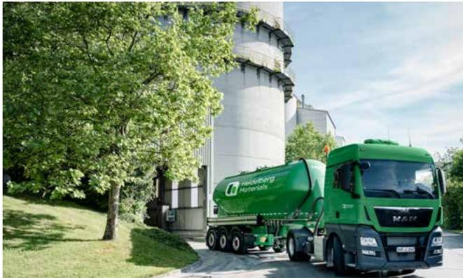
Der fertige Zement wird nach Sorten getrennt in Silos zwischengelagert. Von dort wird er überwiegend als lose Ware über Terminals auf Straßen- und Schienenfahrzeuge oder auf Schiffe verladen. Nur ein kleiner Anteil des Zements erreicht den Kunden als 25 kg-Sackware, abgefüllt durch Rotopacker und gestapelt über automatische Palettieranlagen.
